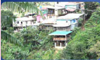
Cantón de Alajuelita, la construcción de viviendas avanza en terrenos propensos a inestabilidad de laderas y desplazamientos.
